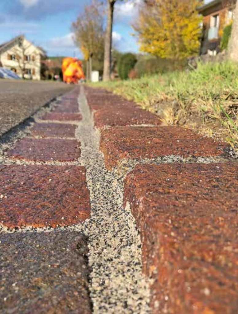
Endzustand der Randsteinsanierung
