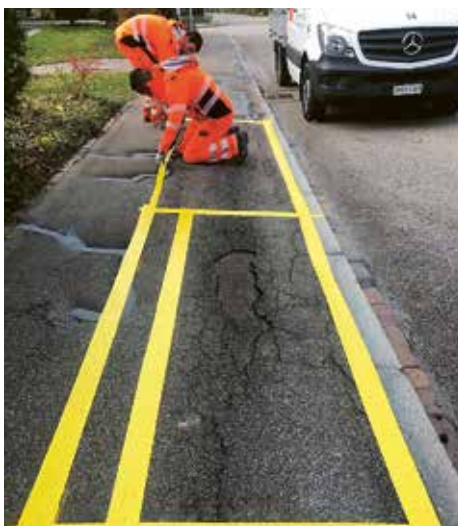
Anwendung mit Flüssigasphalt
