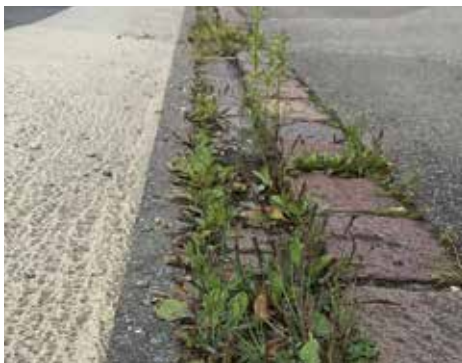
Situation vor Sanierung
