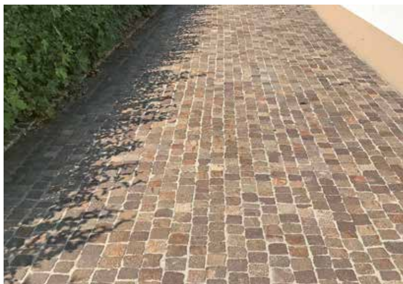
Endzustand der Fugensanierung und Flächenpflästerung
