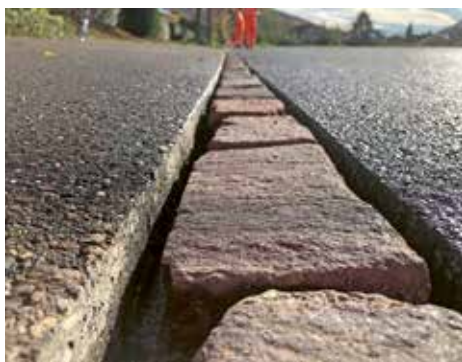
Situation nach Fräsarbeit und Reinigung
