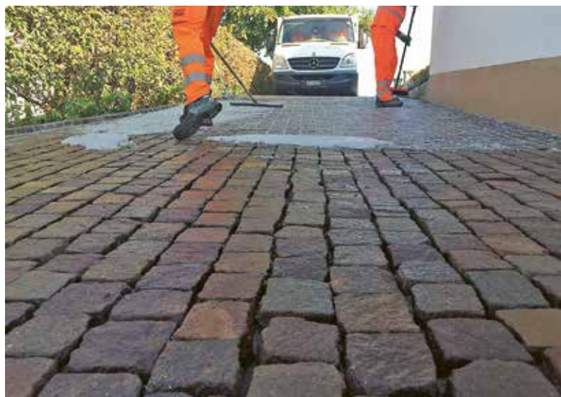
Gereinigte Flächenpflästerung, Fugenverguss
