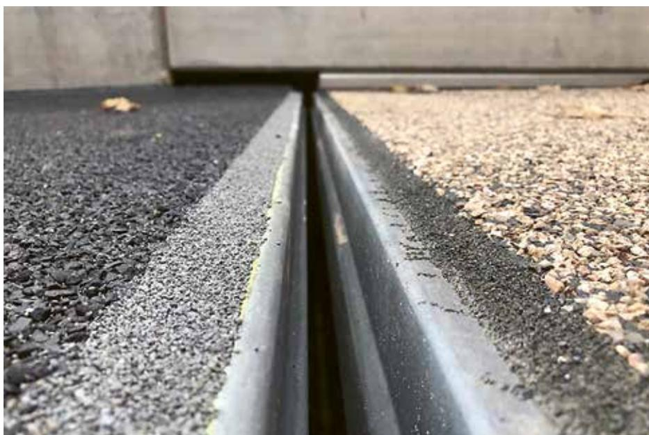
Fuge Gussasphalt – Stahl, Kaltverguss
