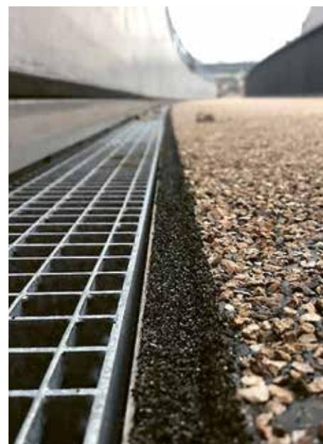
Fuge Gussasphalt – Rinne, Kaltverguss PU
