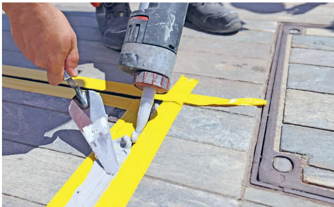
Einbau des Fugendichtstoffes
