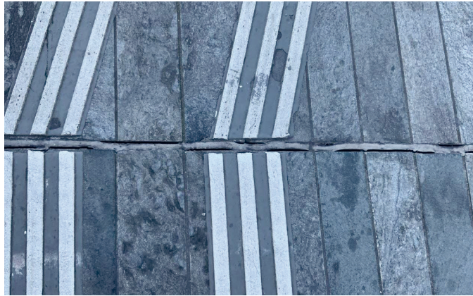
Defekte Fugen
