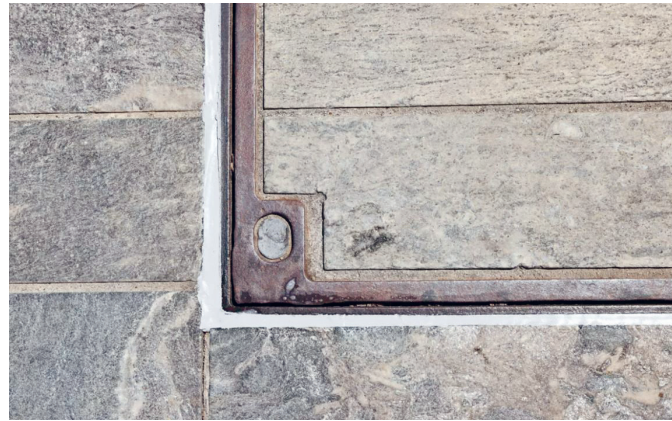
Neu erstellte Fugen
