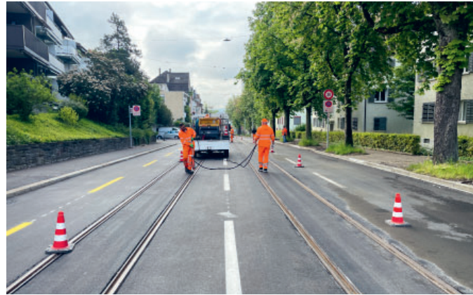
Trocknen der gereinigten Fugenflanken
