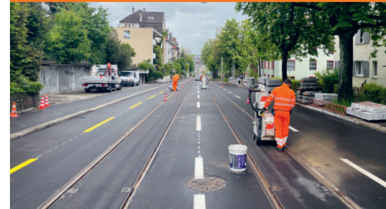
RSAG-Team im Einsatz an der Hönggerstrasse in Zürich
