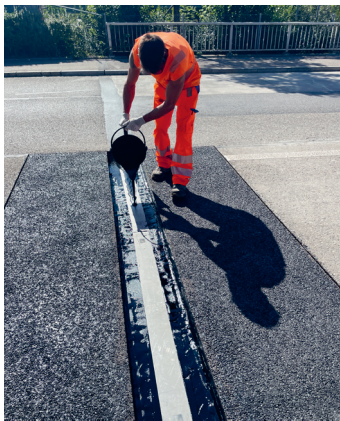
Einbau Vergussmasse/Stützkorn
