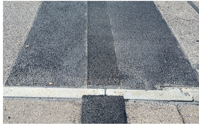
Neu erstellter Fahrbahnübergang
