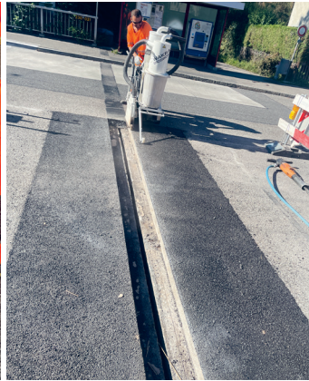
Anschneiden Fugenmulde
