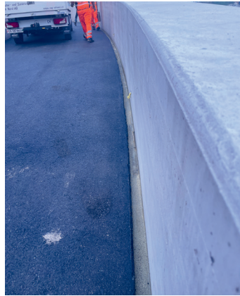
Fugenmulde reinigen
