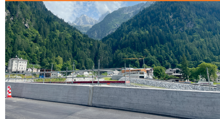
neue Bondasca Brücke, verbindet das Engadin mit Italien
