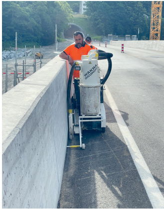
bestehender Belag anschneiden
