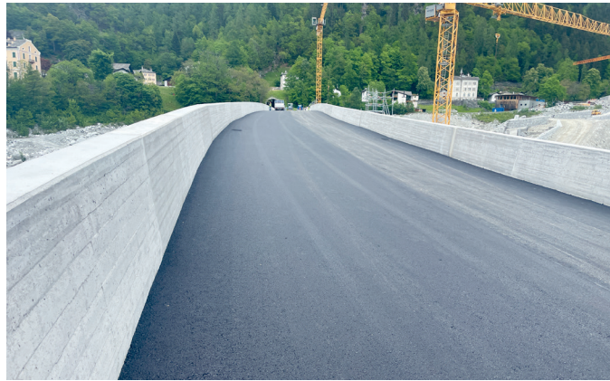
neue Bondasca Brücke
