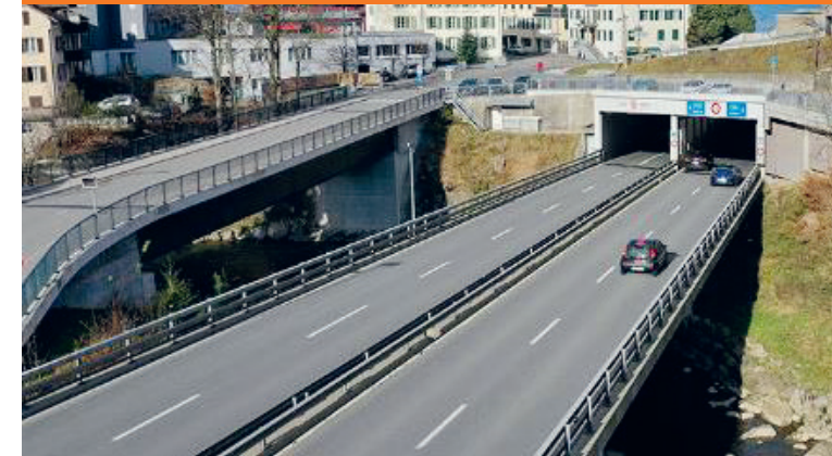
Sihl-Brücke / H8-Tunnel, Schindellegi
