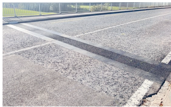
Neu erstellter Fahrbahnübergang
