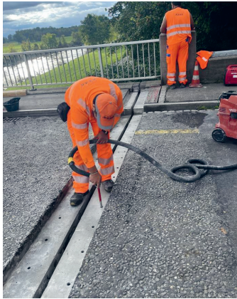
Klebeanker einbohren
