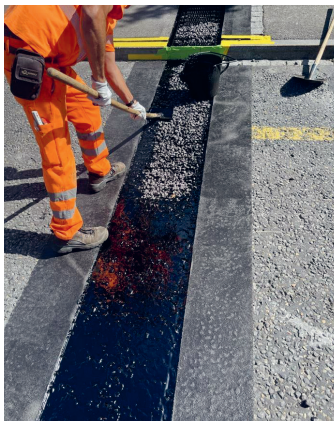
Einbau Stützkorn
