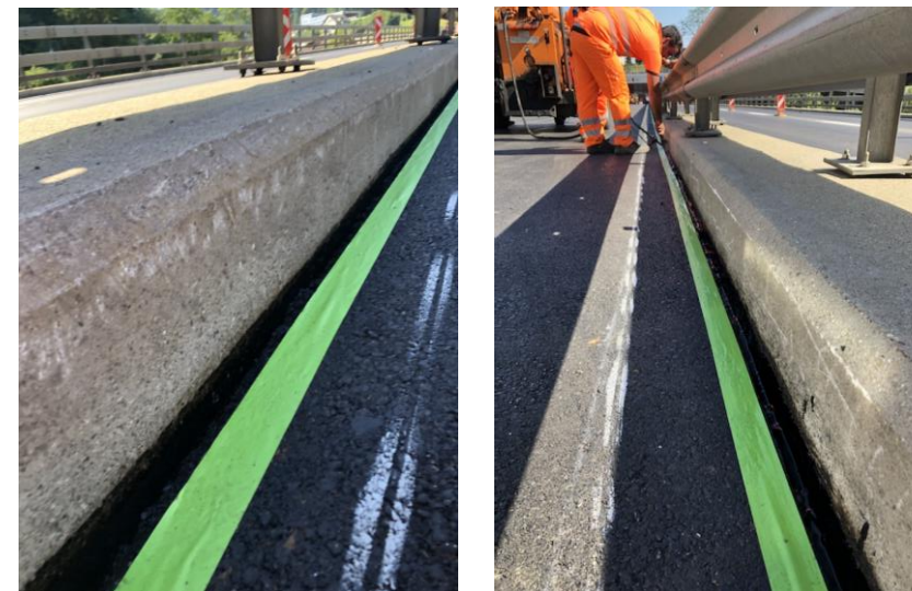
Vorarbeiten: primern und abkleben
