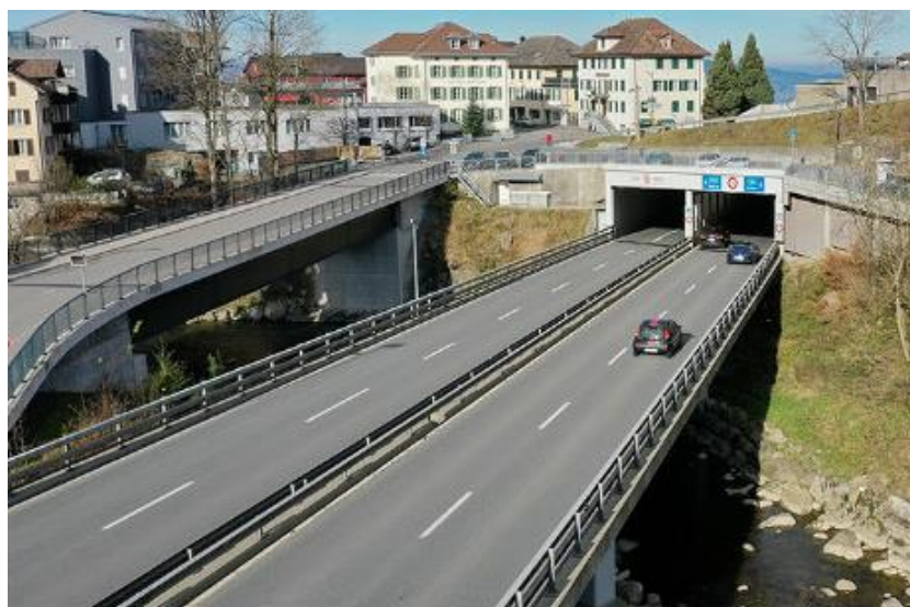
Sihl-Brücke / H8-Tunnel, Schindellegi
