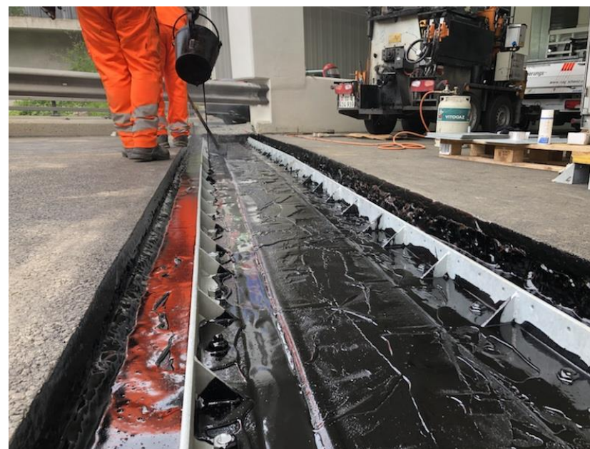
Fugenmulde wird ausgekleidet, Vergussmasse schichtweise eingebaut
