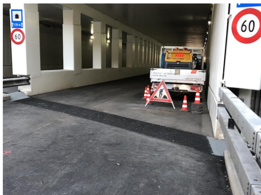
Tunnelleinfahrt Südportal – fertiggestellter Fahrbahnübergang
