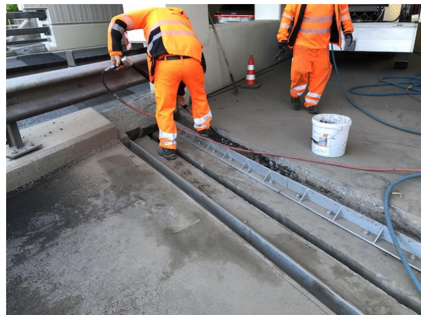
Fugenmulde wird ausgebrochen, Montage Stahlwinkel
