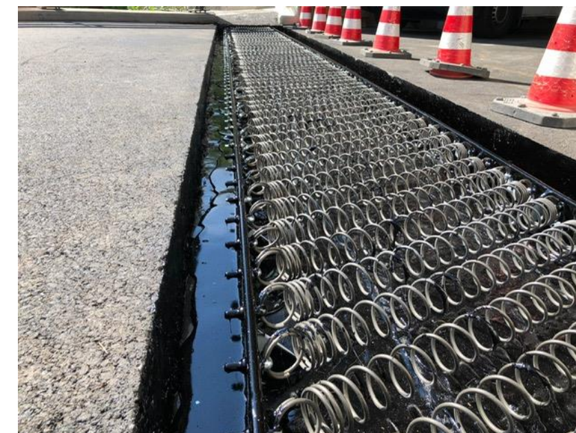
Silent-Joint Federn werden eingebaut
