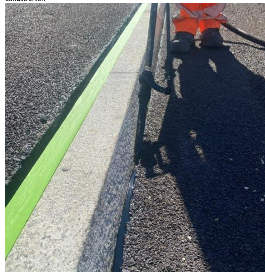
Verguss Bitumen / 2. Schicht
