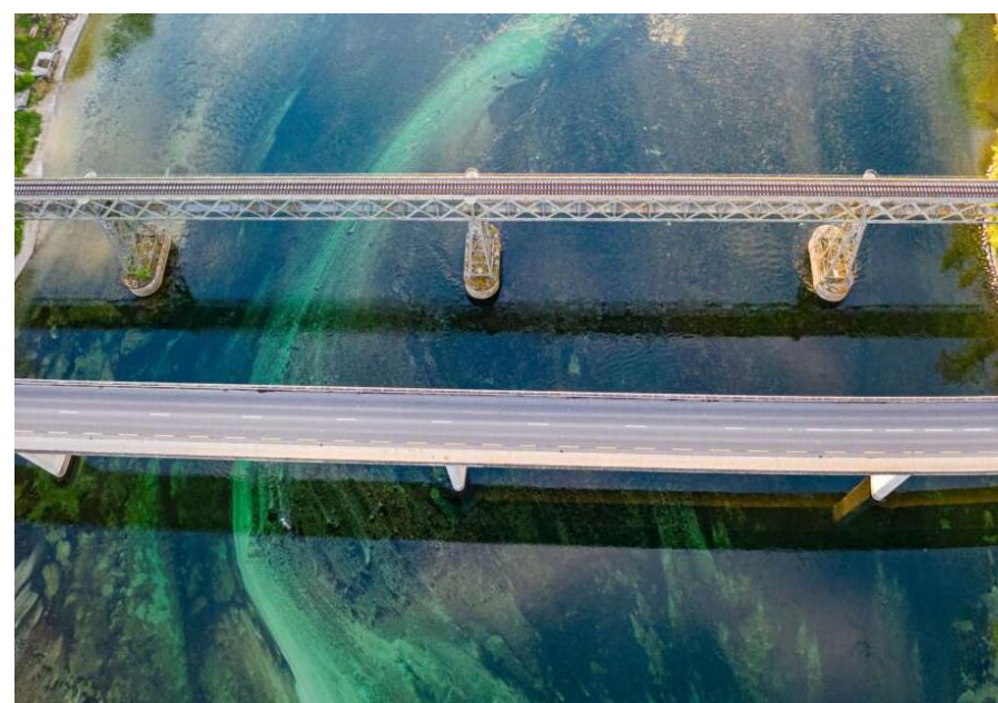
Rheinbrücke neben der SBB-Brücke (Foto: Gemeinde Wagenhausen)
