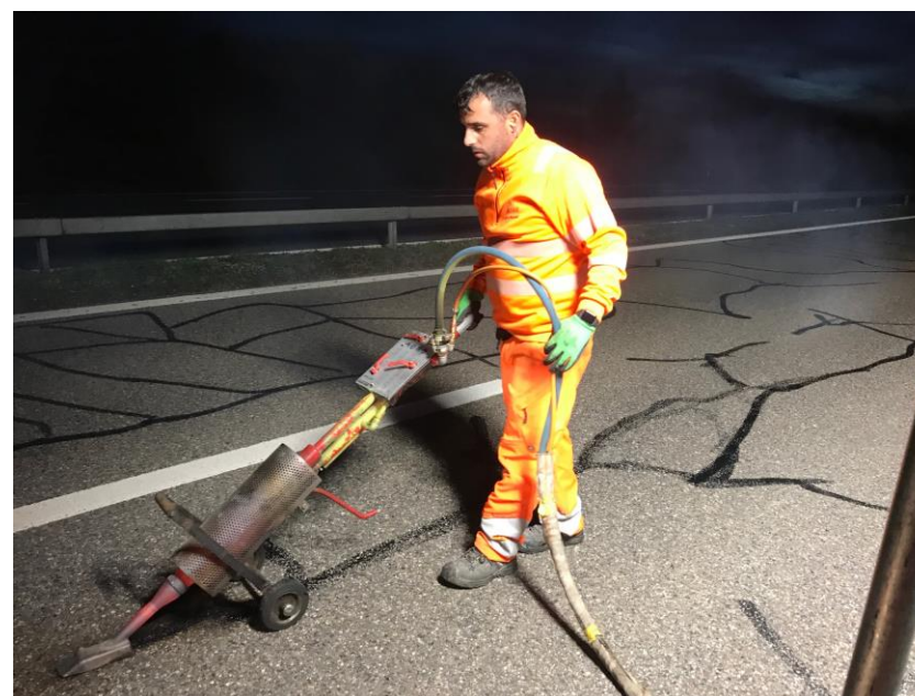
Risse werden mit Heissluftlanze gereinigt und der Belag aktiviert
