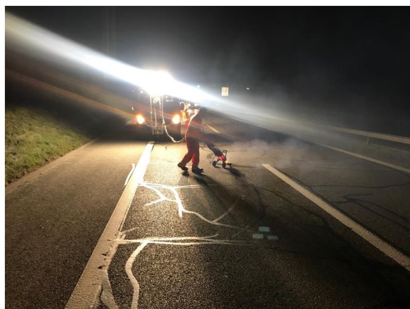
Risse werden mit Heissluftlanze gereinigt und der Belag aktiviert
