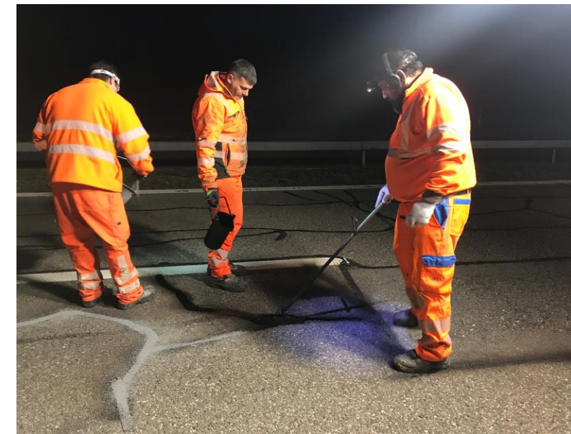
Bitumen wird vergossen und abgesandet
