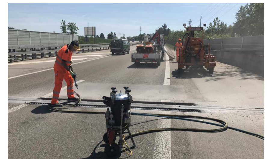
Fugenmulde wird gereinigt, Fugenflanken gesandstrahlt
